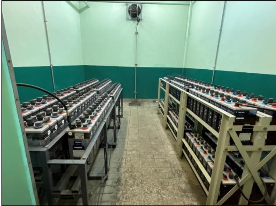
Sala de baterías con extracción forzada y sensor de hidrógeno
