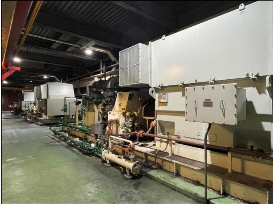
**Bombas de recirculación de agua de refrigeración, unidad V3**
